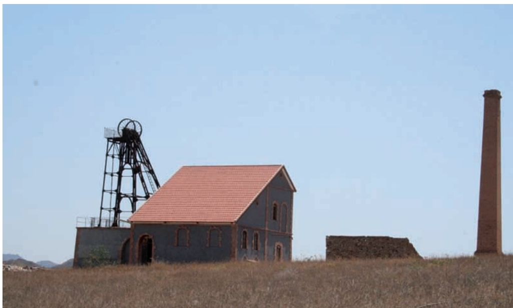
CASTILLETE, CASA DE MÁQUINAS Y CHIMENEAS DE PEDRERAS VIEJAS. MAZARRÓN, MURCIA. FOTOGRAFÍA CEDIDA POR LA DIRECCIÓN GENERAL DE BELLAS ARTES Y BIENES CULTURALES DE LA COMUNIDAD AUTÓNOMA DE LA REGIÓN DE MURCIA.
